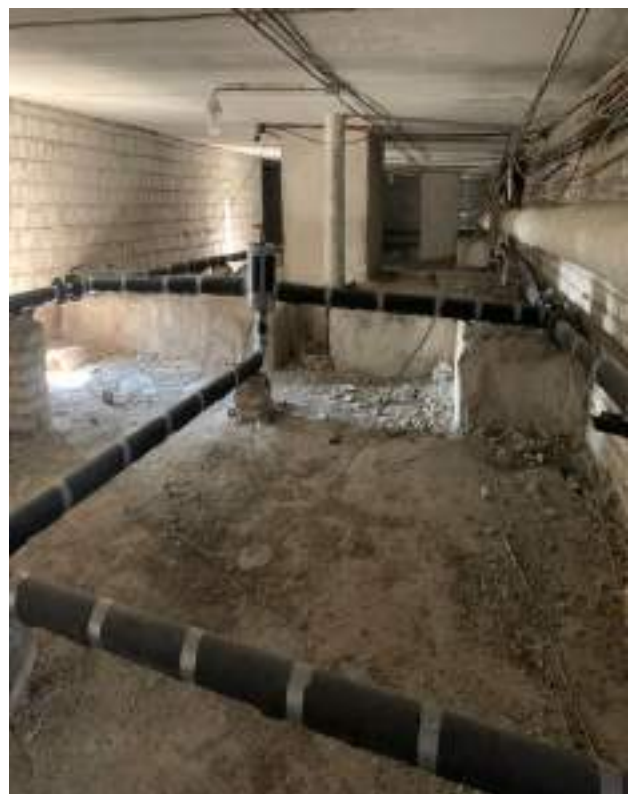
Ремонт Инженерных магистралей холодного, горячего водоснабжения, а также центрального отопления по Адресу Кастанаевская ул. д., 9 корп. 2
