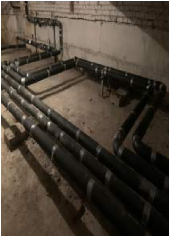
Ремонт Инженерных магистралей холодного, горячего водоснабжения, а также центрального отопления по Адресу Кастанаевская ул. д., 9 корп. 2
