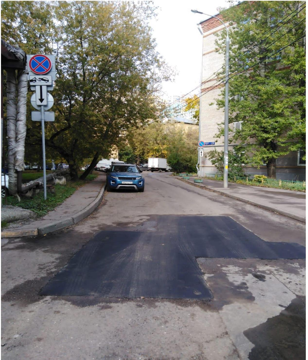
В зимний период отремонтировано 1187 м<sup>2</sup> с применением литой асфальтобетонной смеси.
